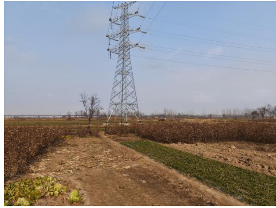
图6-2 架空输电线路周围恢复情况2
