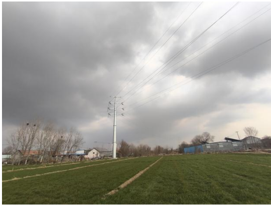
图6-3 架空输电线路周围恢复情况3
