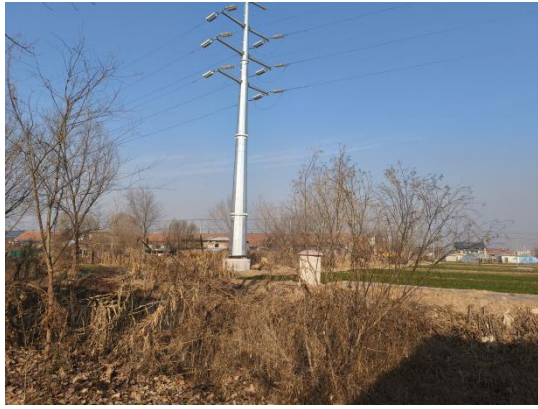
图6-1 架空输电线路周围恢复情况1
