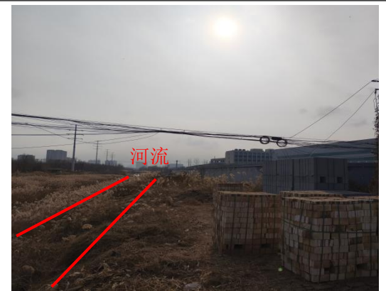
图6-6 跨越河流情况（未在河中立塔）
