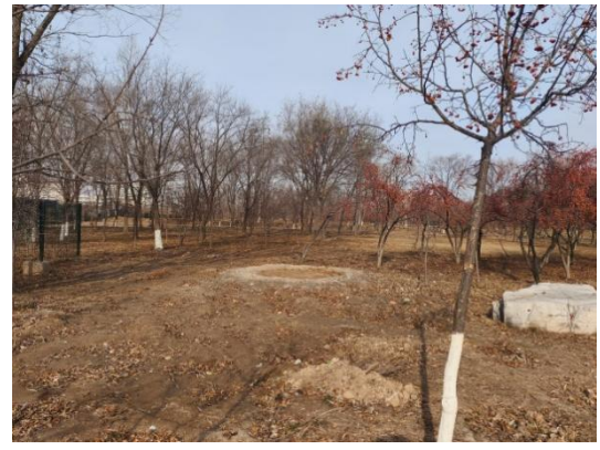
图6-4 拆除塔基处周围恢复情况
