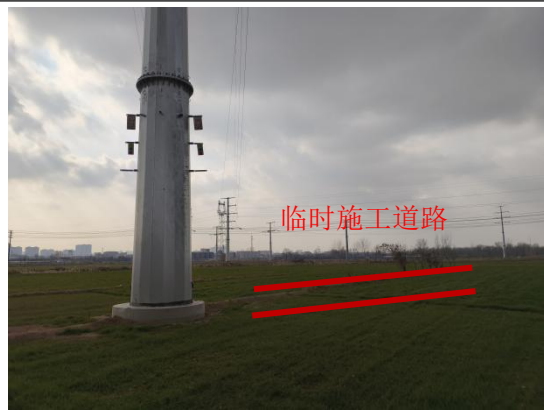
图6-5 临时施工道路恢复情况
