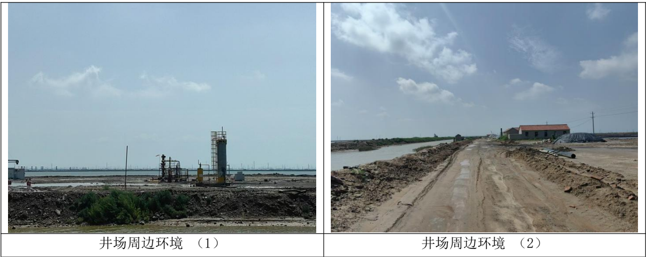
图 7 井场现状恢复照片
