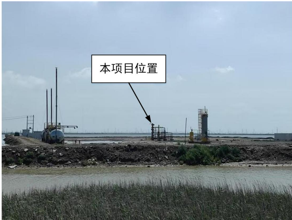
图1 项目现状照片
