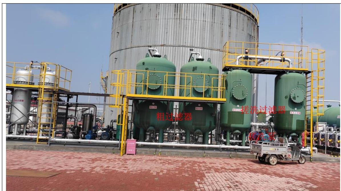
图 3.2-2 改造后采出水处理系统现场照片
