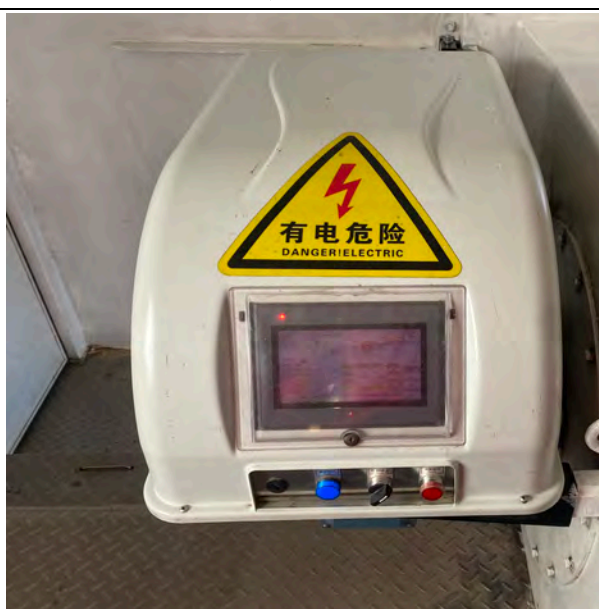
高干度锅炉低氮燃烧器
