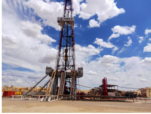
图 2-3 施工现场照片
