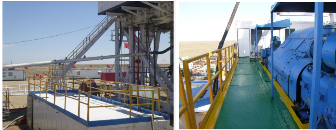
图 2-2 施工现场照片
