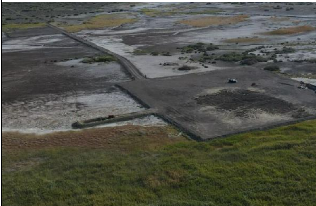
哈山斜 4 井场航拍图
