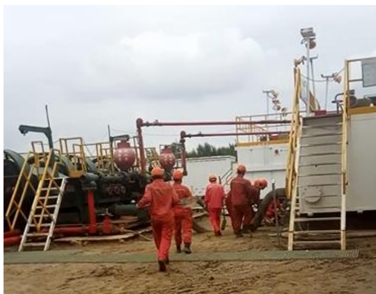
图 7 钻井队应急演练现场照片
