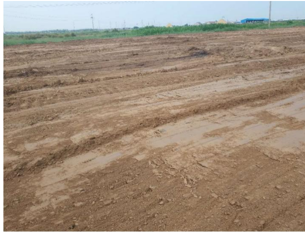
图9 施工结束现场平整照片
