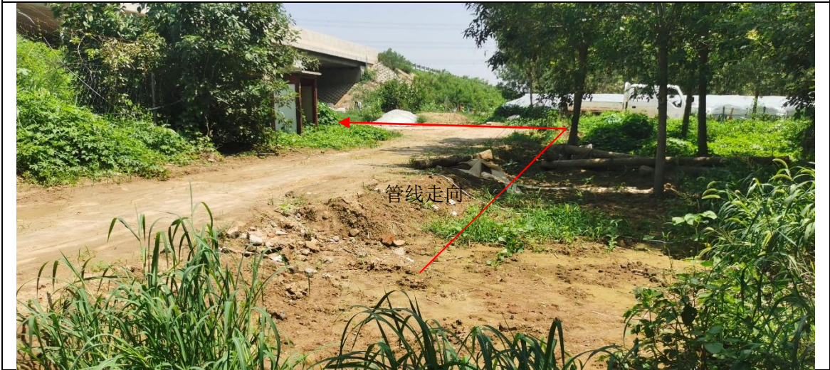
林 102-23 管线涵洞穿越 G2516 生态恢复情况
