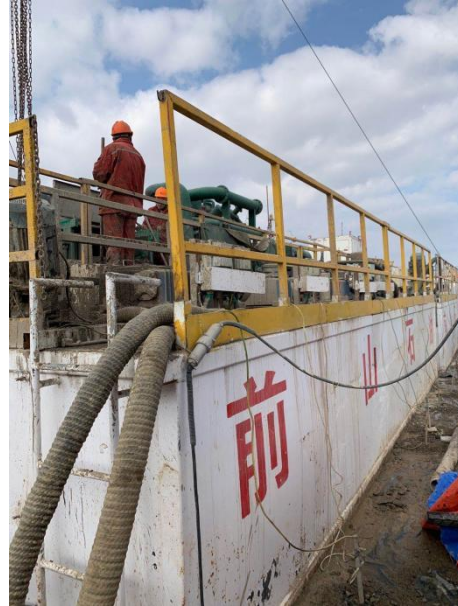
泥浆不落地现场处理照片
