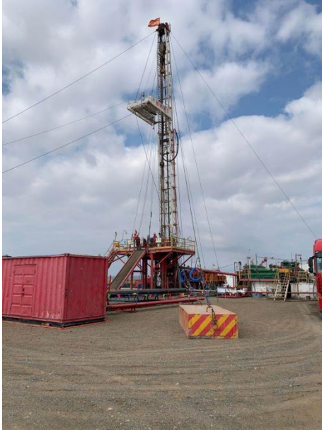
现场施工照片
