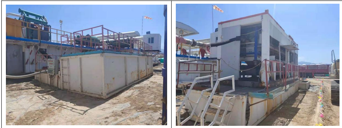
图 2-3 施工现场照片
