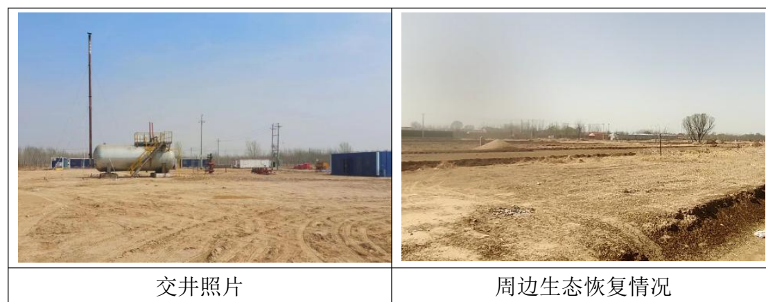
图 4-1 井场现状及生态恢复情况
