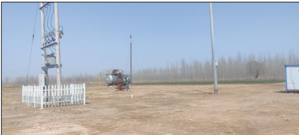
图 2-1 项目临时占地目前现状图
