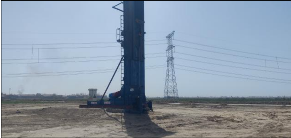
图 2-3 项目临时占地目前现状图
