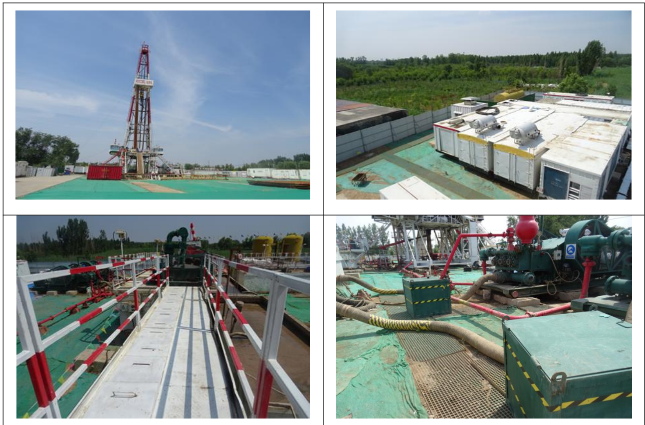
图 1 钻井施工现场照片
