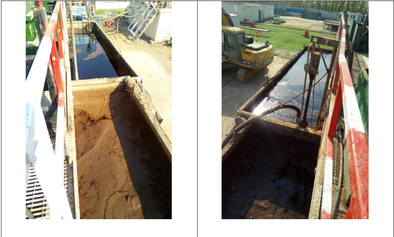
图 8 泥浆不落地工艺现场图
