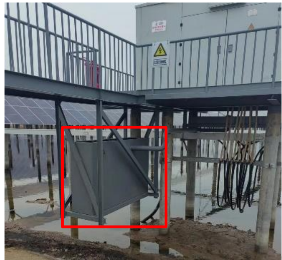
新建事故贮油池
