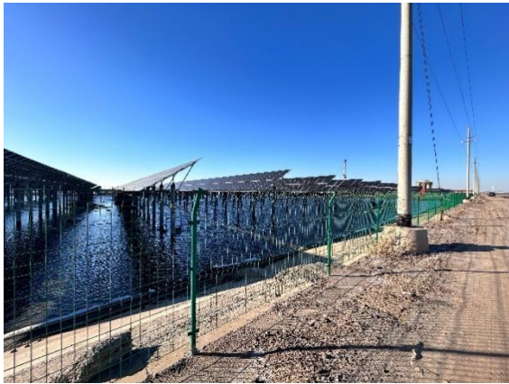
新建光伏组件
