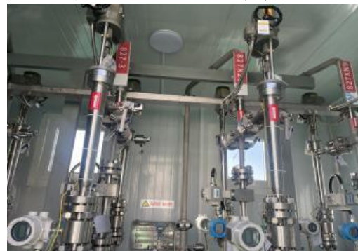
图 3.2-10 配注站五井式混阀泵撬
