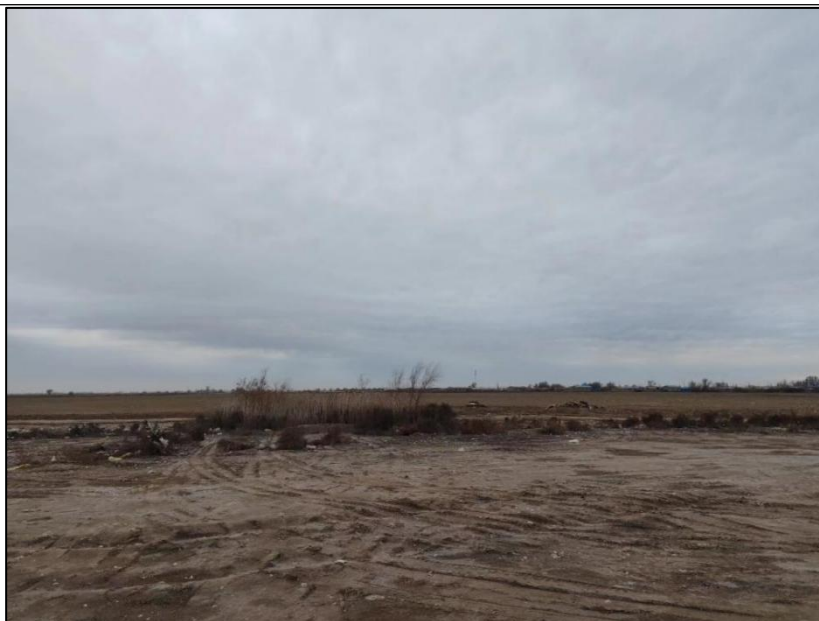
图 4-1 井场平整及生态恢复情况照片
