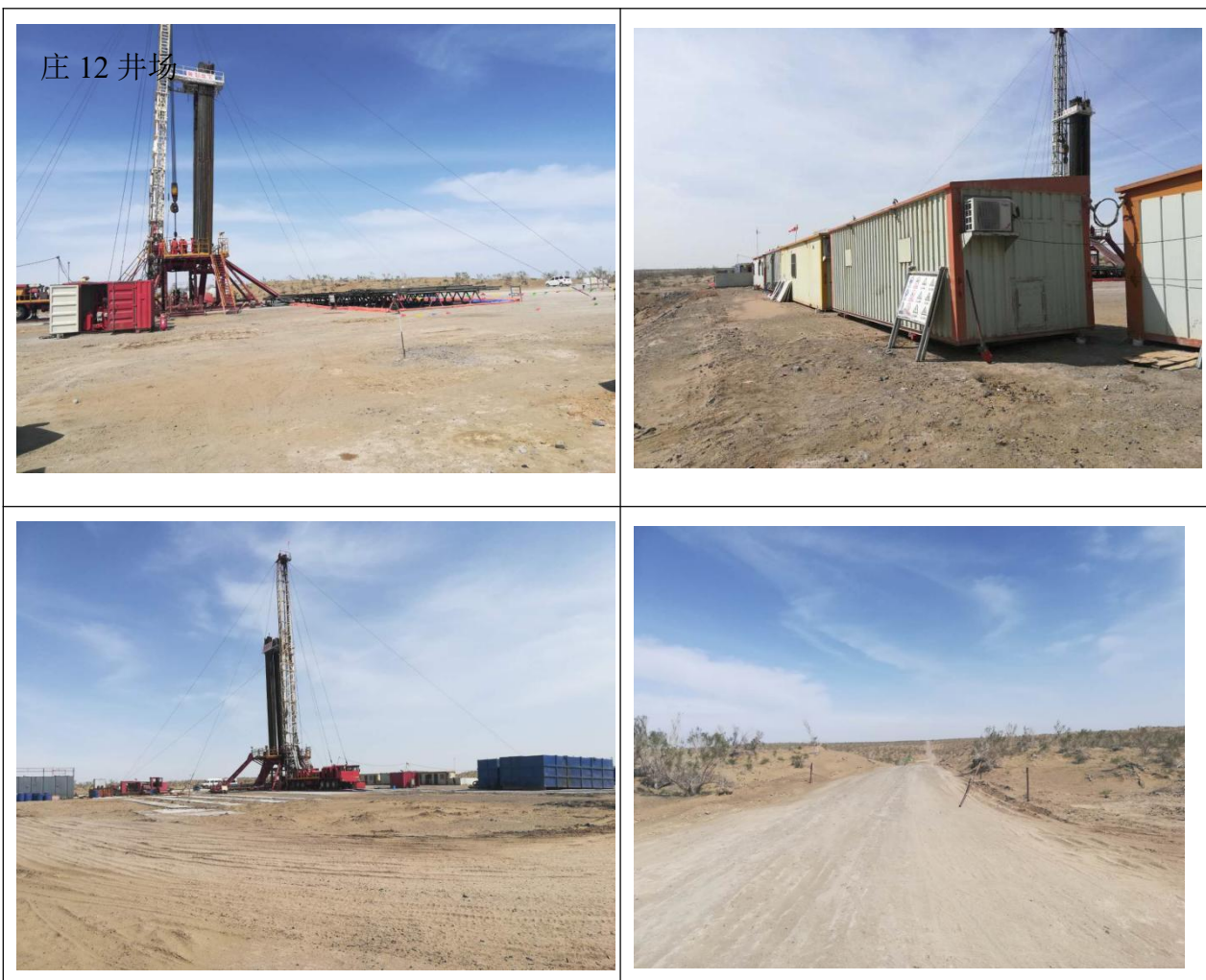
图 2-3 施工现场照片
