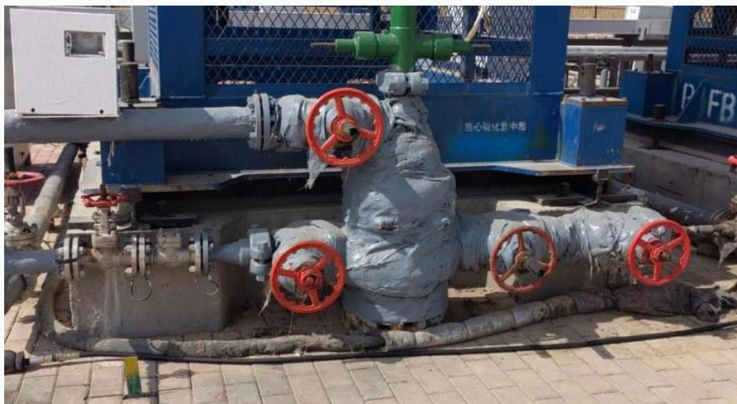
图 4-4 密闭流程油气套管建设现场情况
