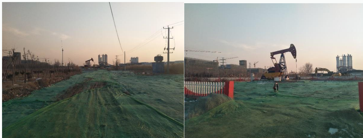
图 4-2 施工期扬尘防护情况
