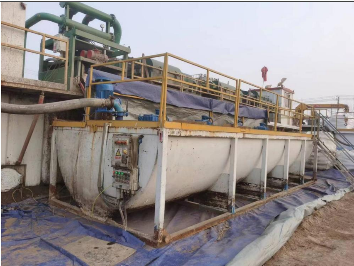
图 4-3 施工期泥浆不落地现场情况
