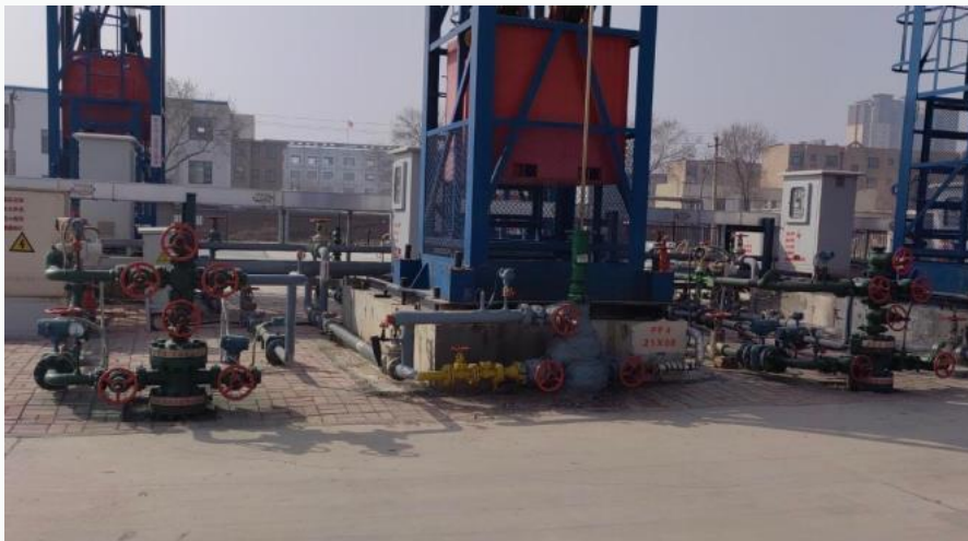
图 4-4 密闭流程油气套管建设现场情况
