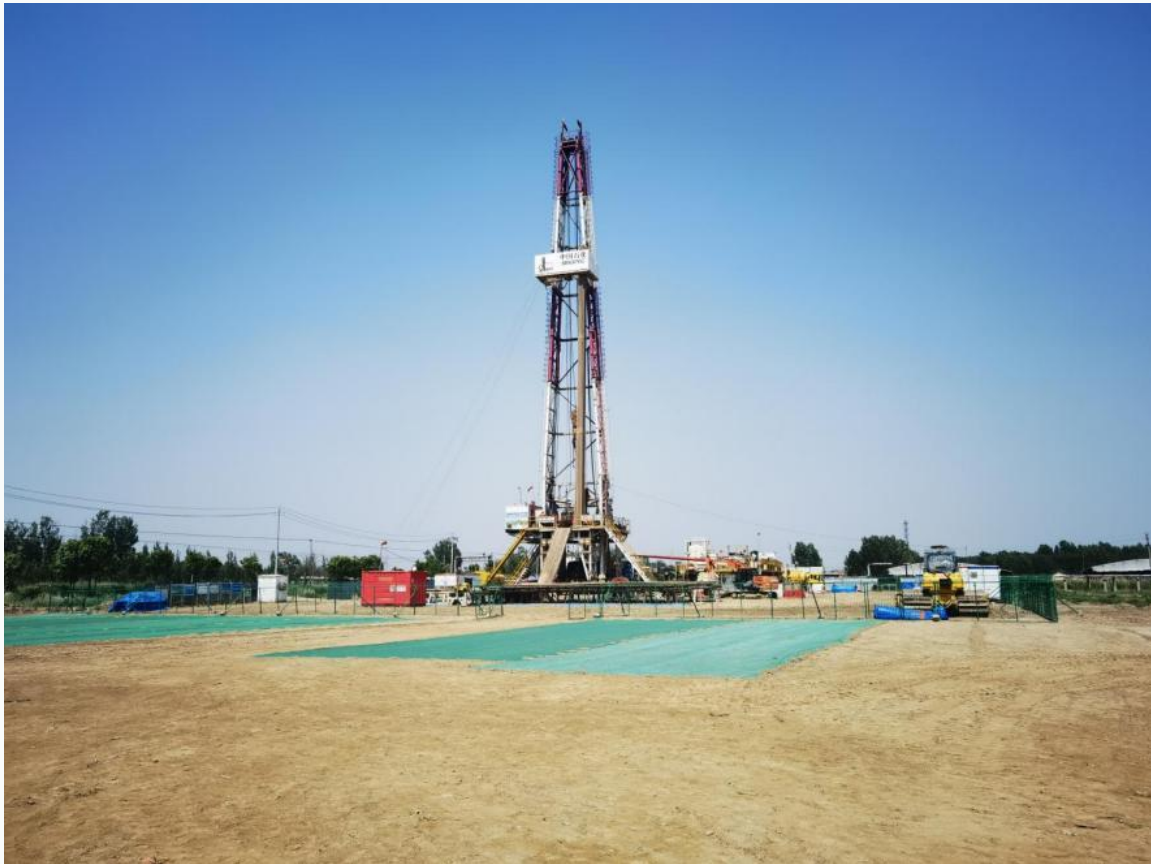
图 4-2 施工期扬尘防护情况
