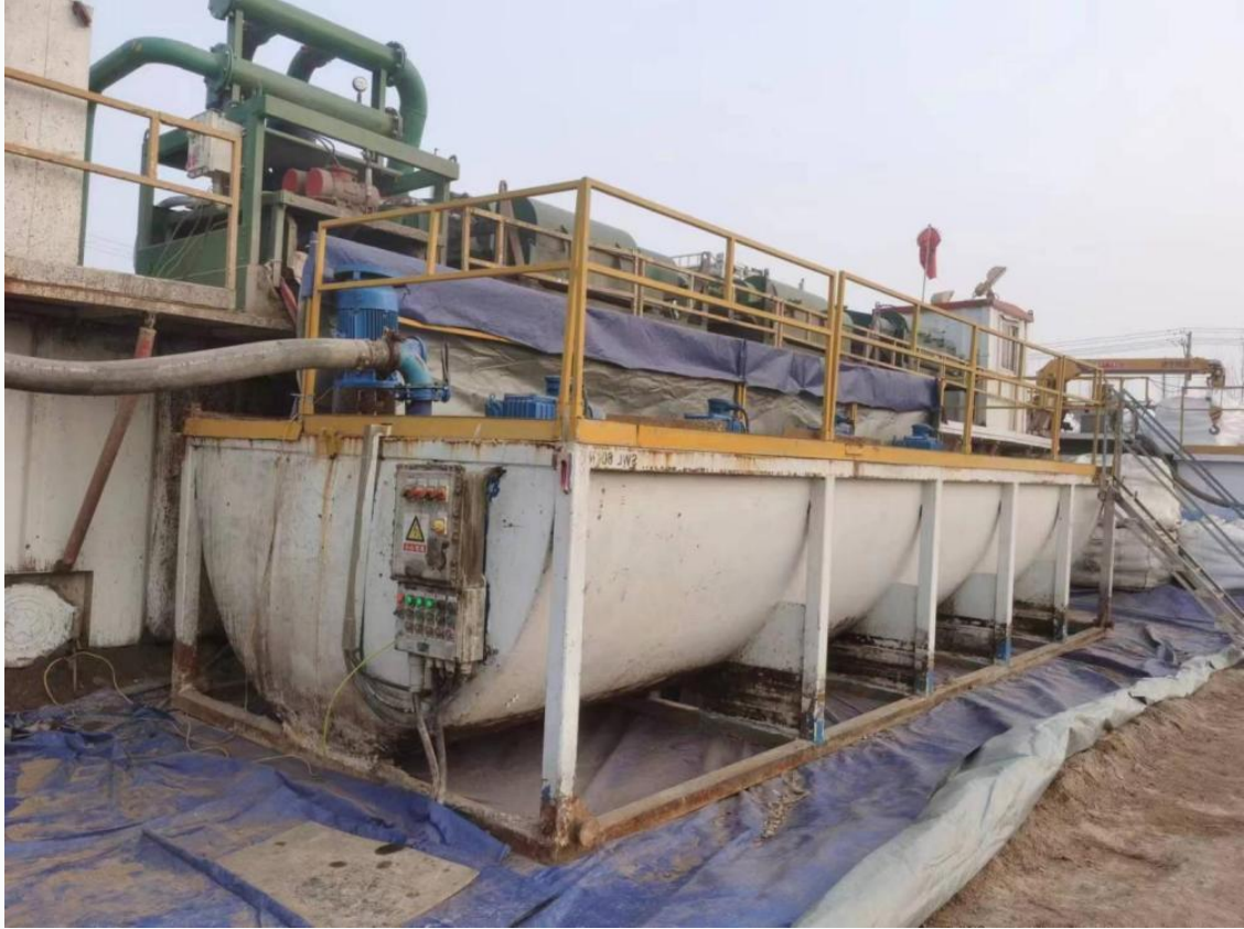
图 4-3 施工期泥浆不落地现场情况
