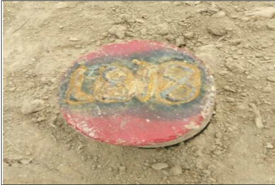
图 2-2 罗 818 井完井井口现状
