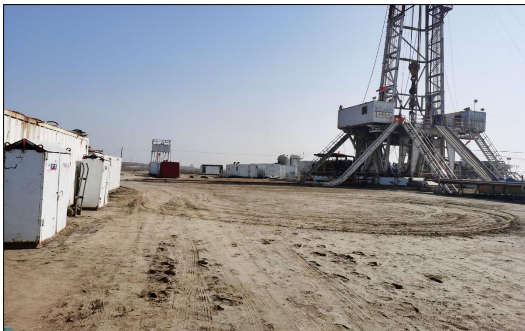
图 4-1 施工现场照片
