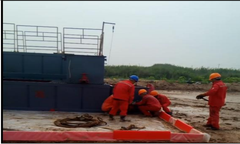
图 4-2 垦斜 730 井应急演练现场照片
