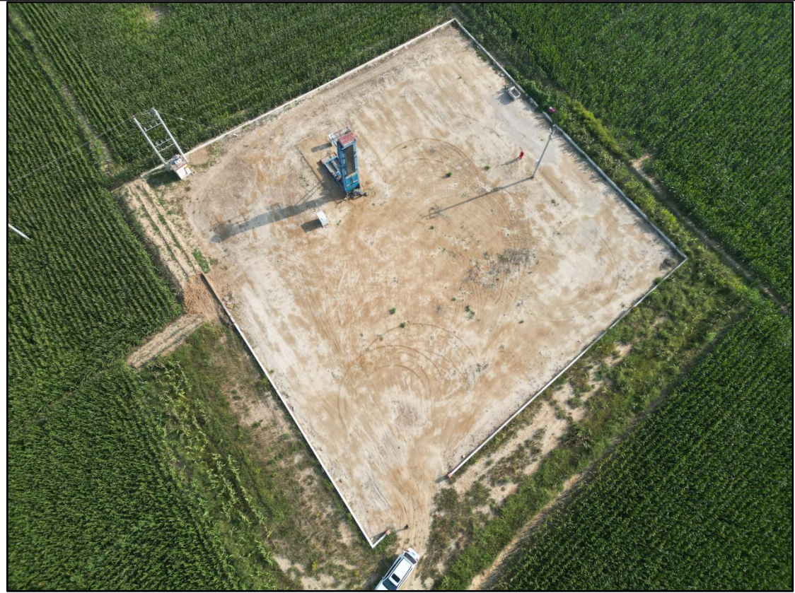
图 2-1 项目井场周围临时占地生态恢复情况现状
