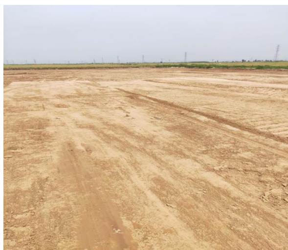
完钻后井场地面现场照片
