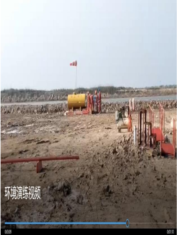
图 5 钻井、试油应急演练现场
