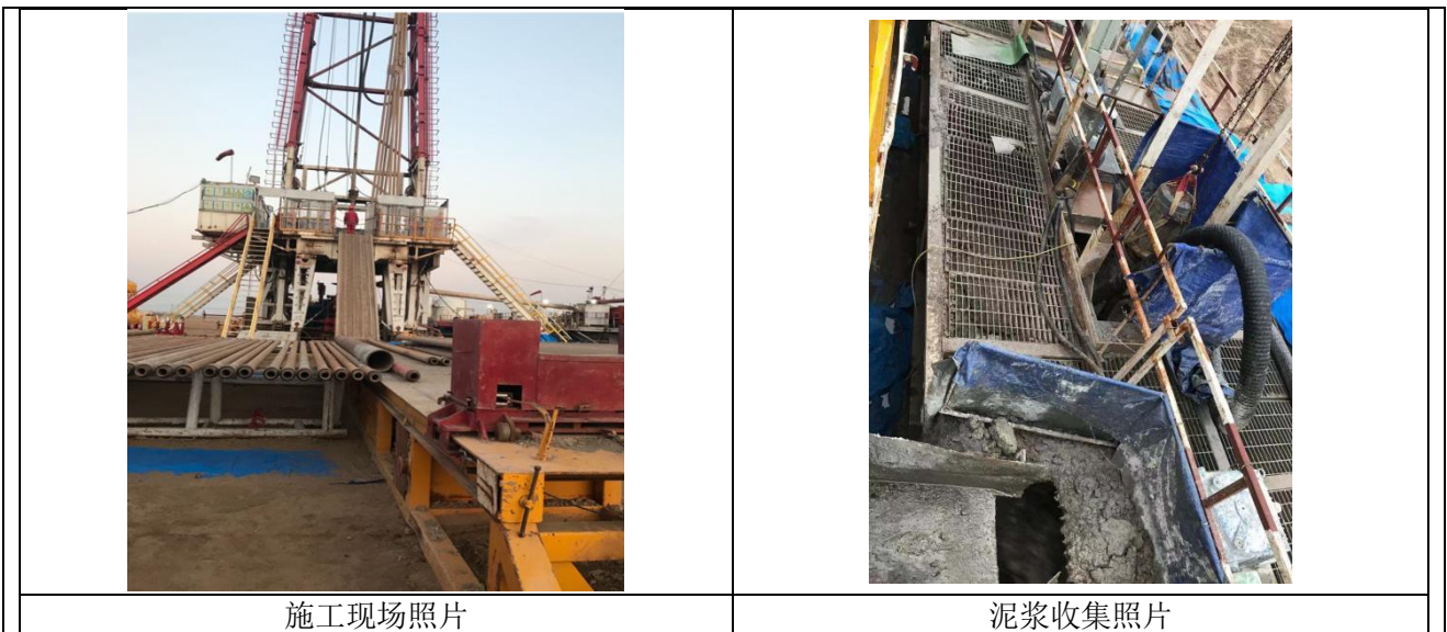
图 1 施工现场照片图
