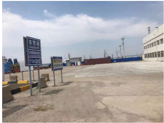
11#泊位施工前后
