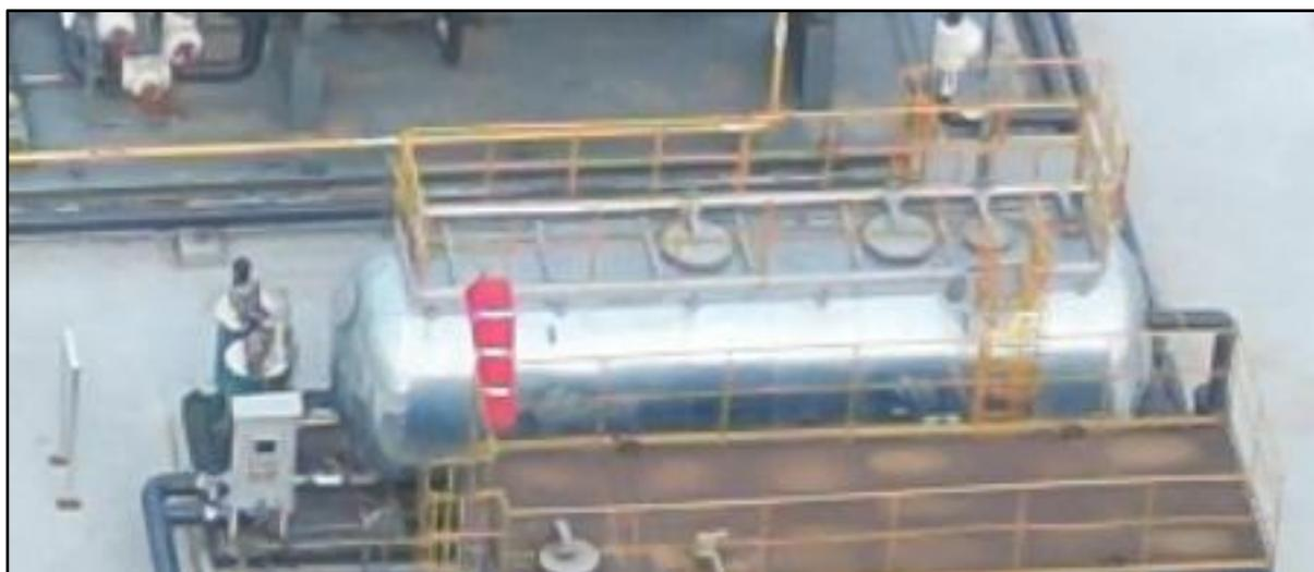
图 5.2-1 压力斜板除油装置现场照片
