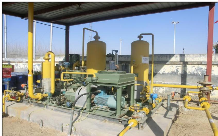
图 3.9-1 高青联合站大罐抽气装置现场照片
