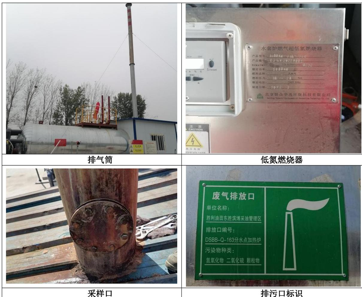
图 5.2-2 加热炉现场照片
