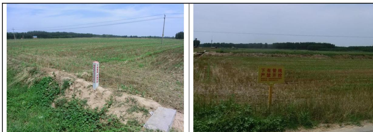
图 5.1-1 本项目管线标志桩、警示桩现场照片
