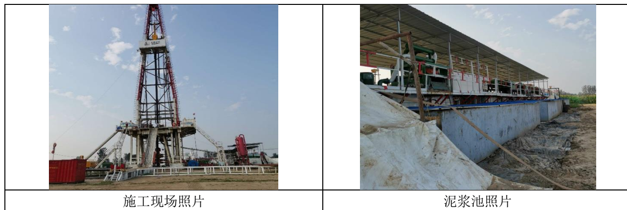
图 1 施工现场照片图
