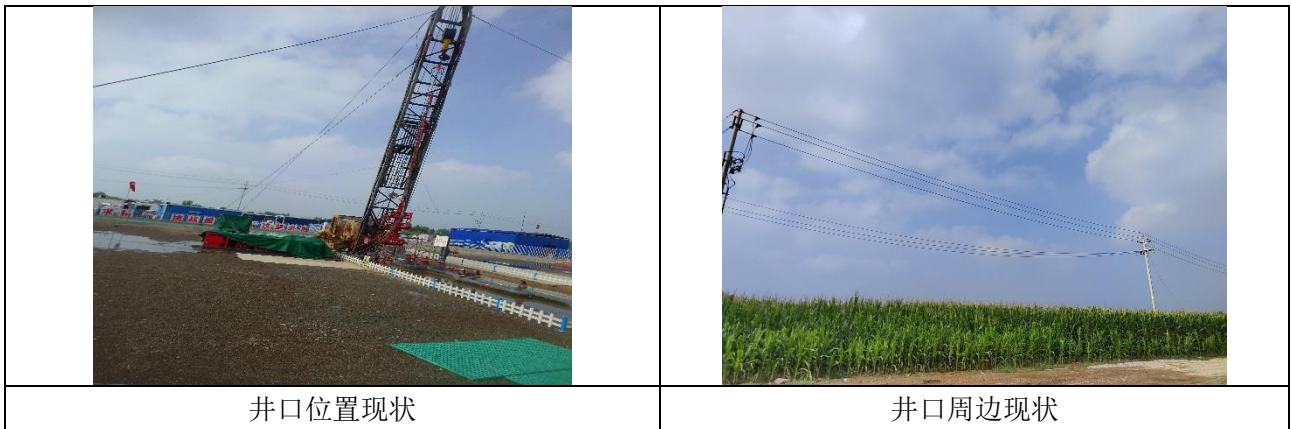
图 4 井场现状恢复照片
