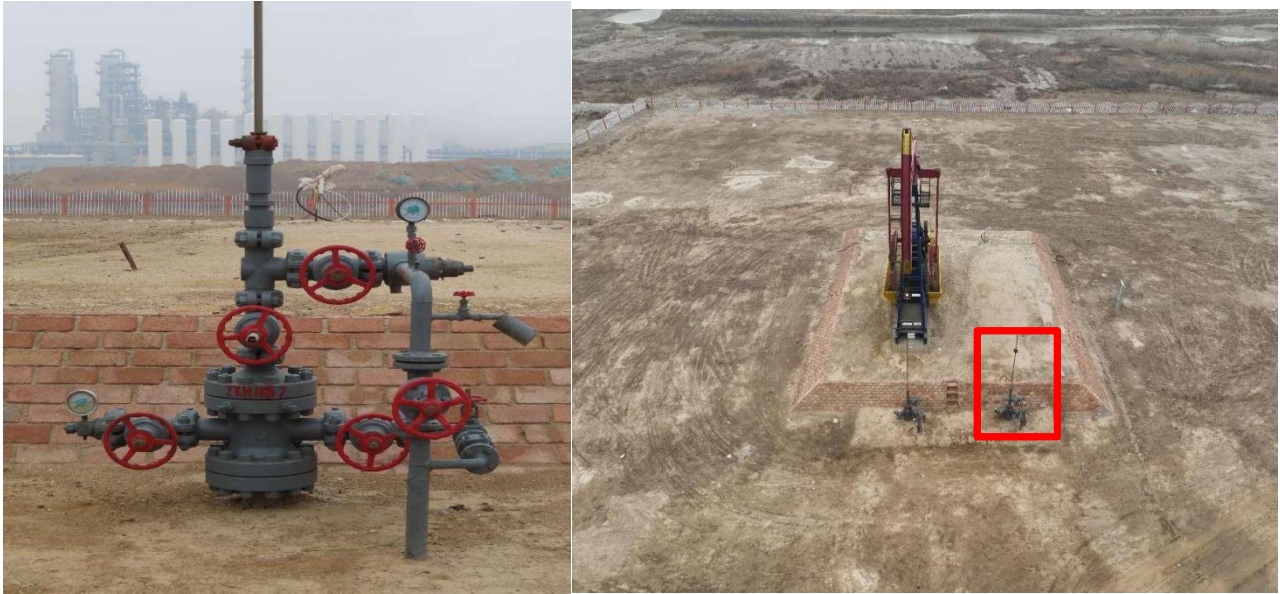
图 4 井场现状恢复照片
