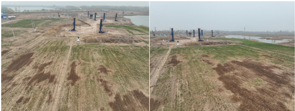
图 5 井场现状恢复照片
