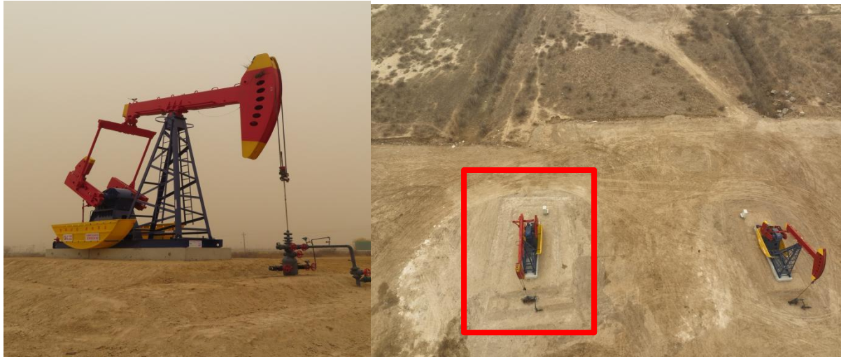
图 4 井场现状恢复照片
