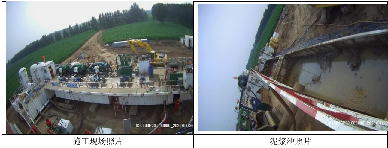
图 1 施工现场照片图
