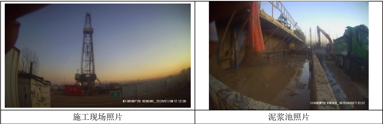
图 1 施工现场照片图
