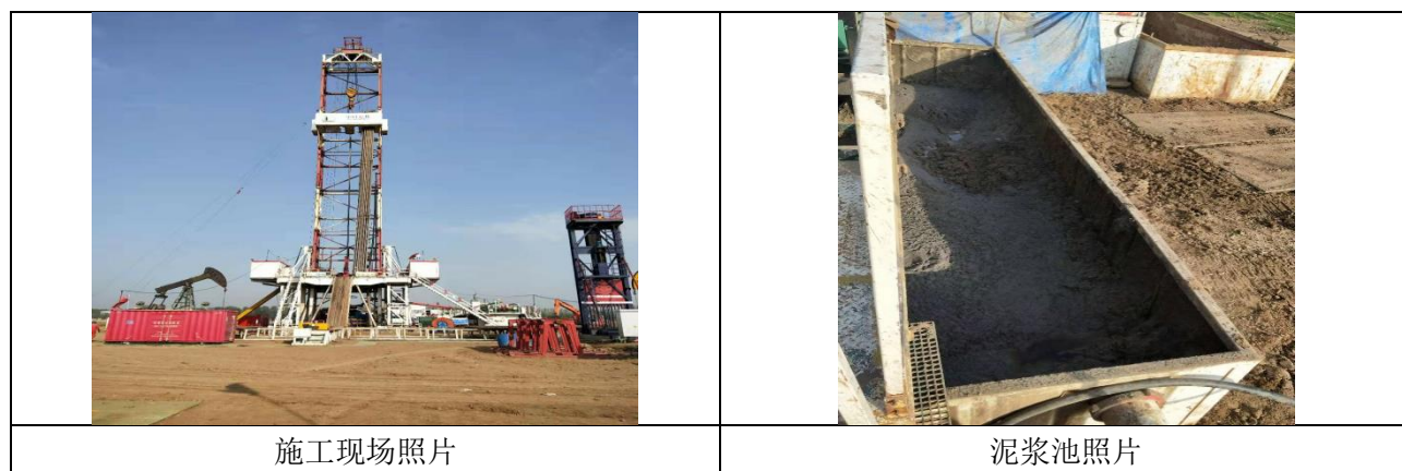
图 1 施工现场照片图
