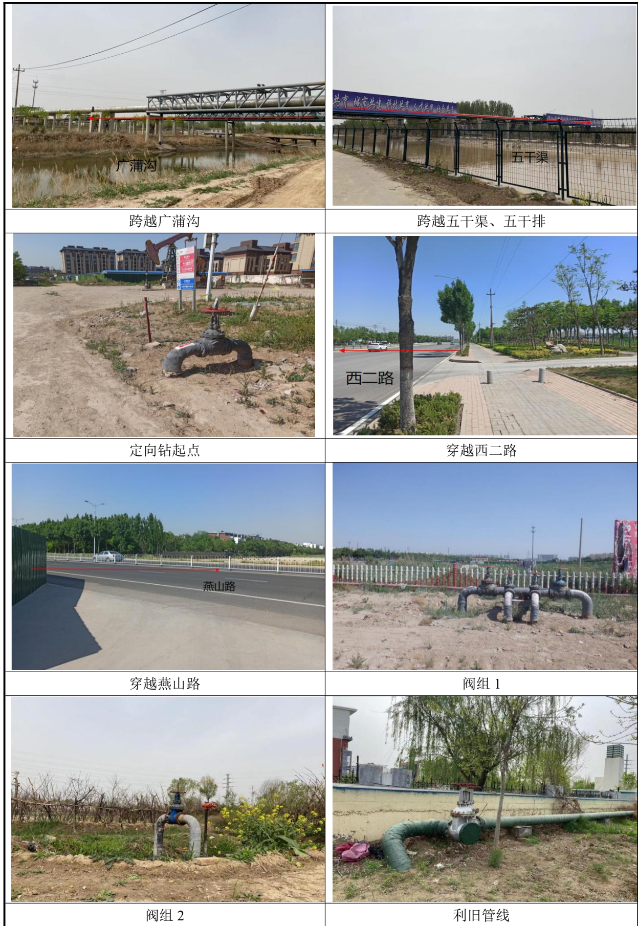
图 3-3 现场实际建设情况
