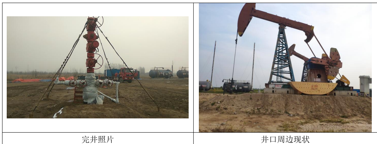
图 5 井场现状恢复照片
