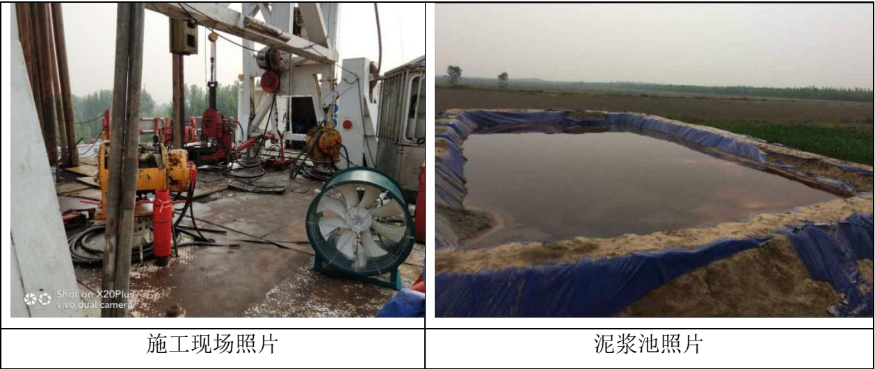
图 1 施工现场照片图
