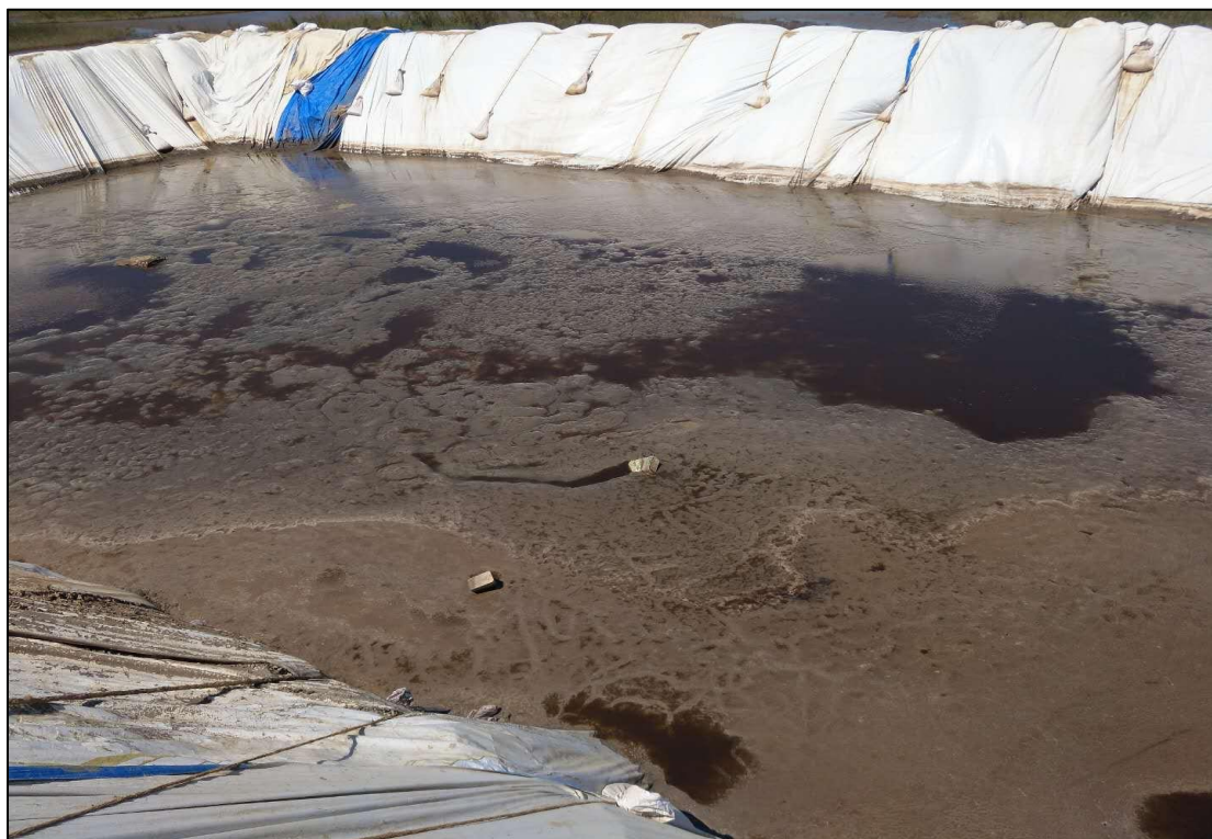
图 2-5 泥浆循环池铺设防渗材料
