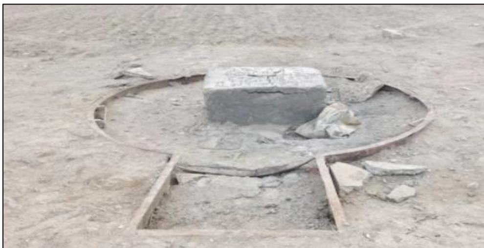
图 2-1 墩斜 3 预探井井口现状
