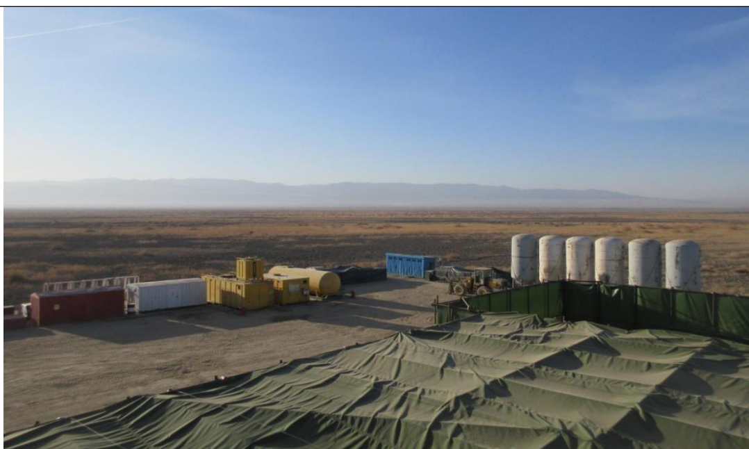
图 4-2 施工扬尘防治措施照片
