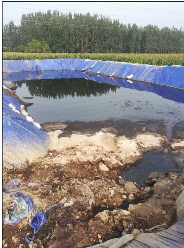
图 2-3 泥浆循环池铺设防渗材料
