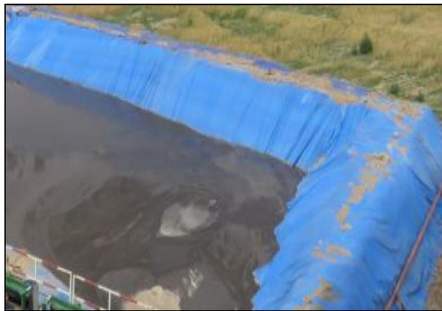
图 2-4 泥浆循环池铺设防渗材料
