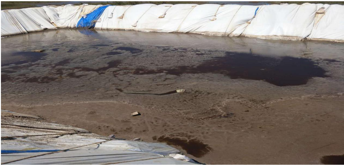
图 2-3 泥浆循环池铺设防渗材料
