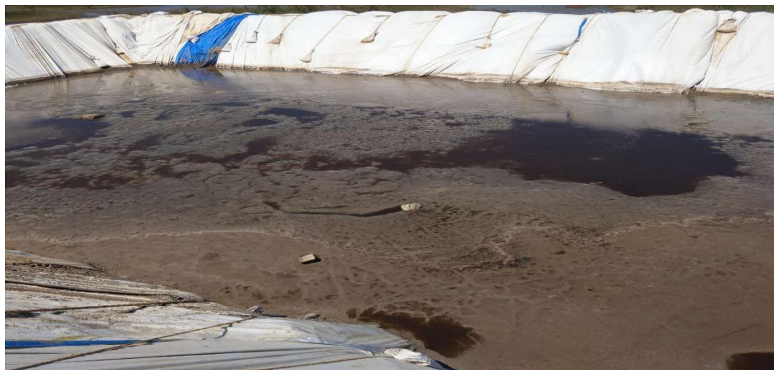
图 2-3 泥浆循环池铺设防渗材料
