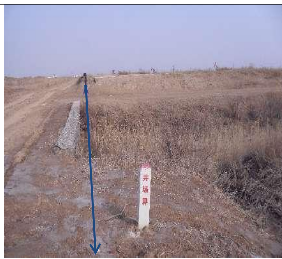
管线跨越沟渠
