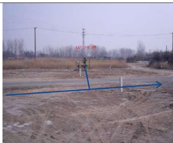
大开挖穿越共青团路
