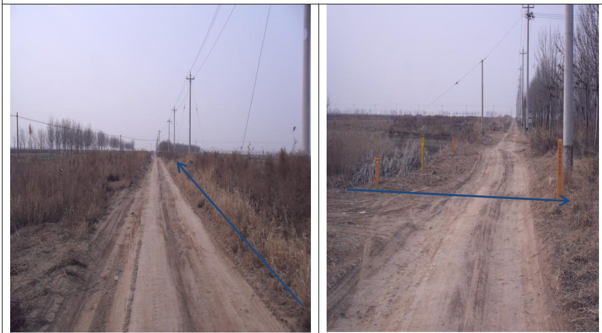
管线沿线生态恢复情况照片
