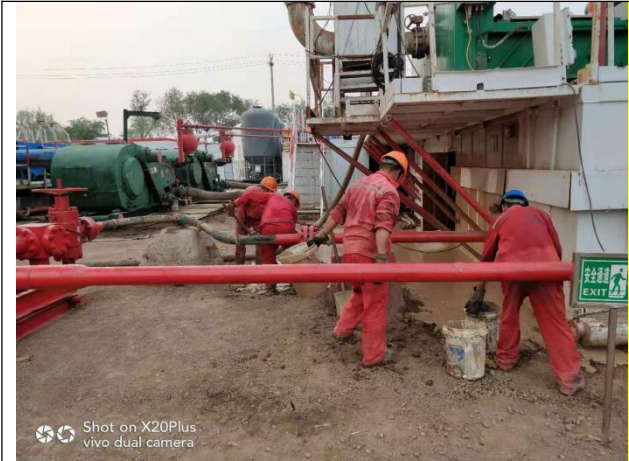
图 4-4 钻井单位应急演练现场图
