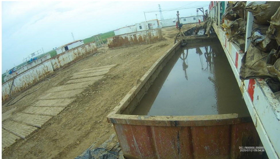
图 4-3 泥浆不落地照片
