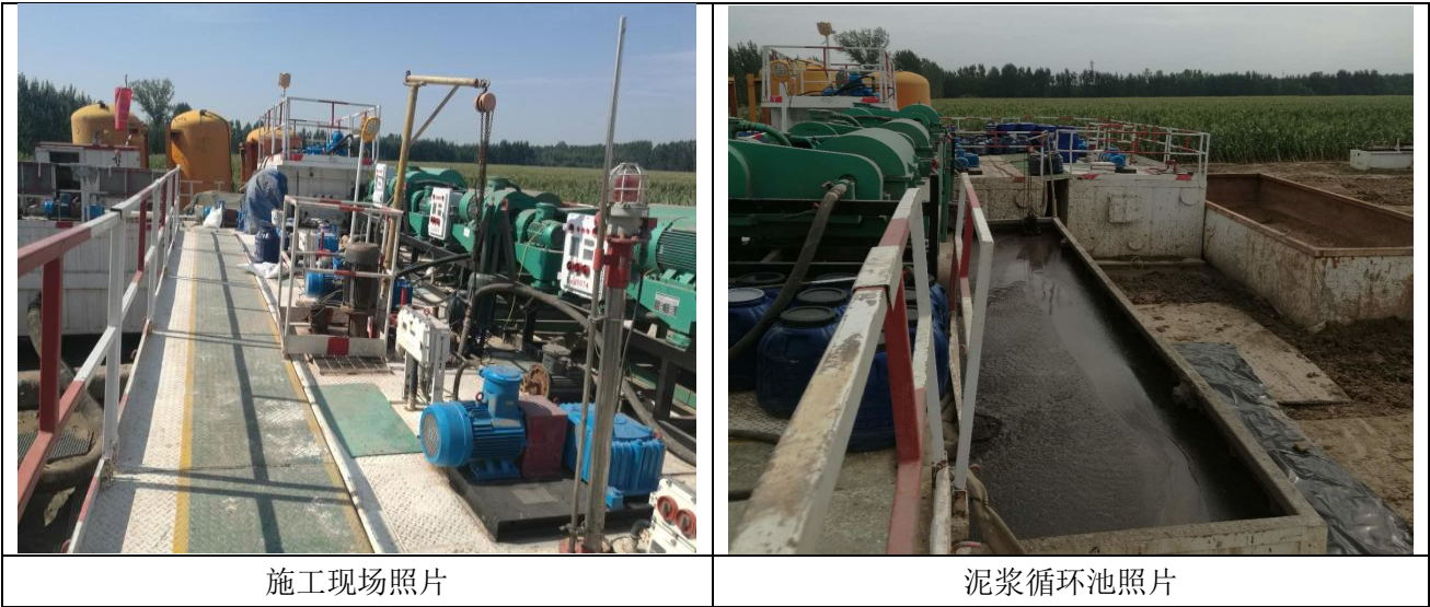
图 1 施工现场照片图
