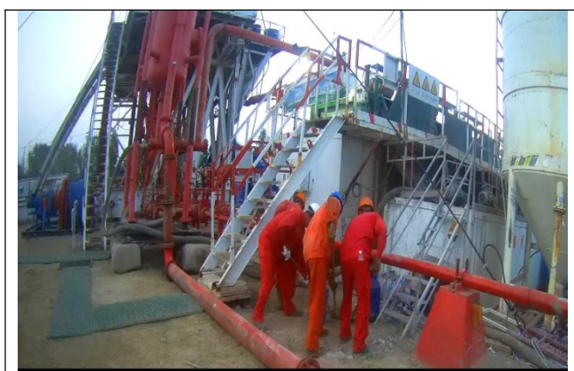
钻井单位应急演练现场图
